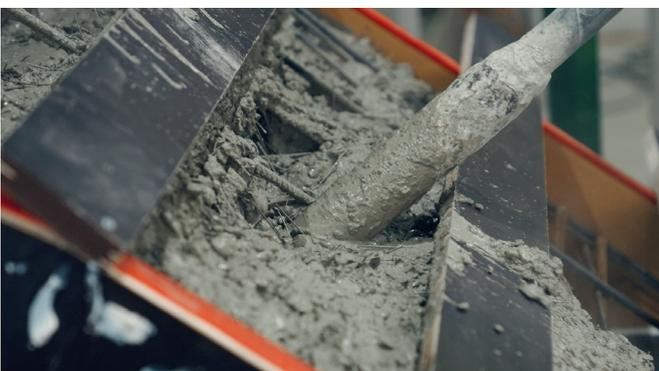
*Der Einbau des Stahlfaserfrischbetons mit der Stabils-Faser erweist sich als sehr einfach. Die Fasern zeigen eine sehr homogene Verteilung im Frischbeton und keine Neigung zur Igelbildung.*
