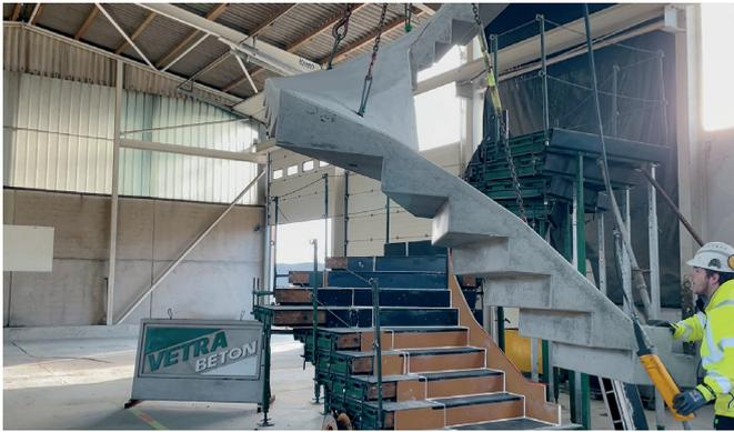
Abheben der CO<sub>2</sub>-reduzierten Betonfertigteiltreppe. Durch den Einsatz einer Kombi-Bewehrung kann die Treppe sehr materialeffizient hergestellt werden.
